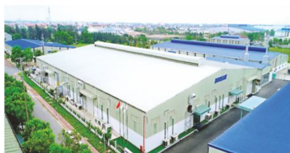
Dự án Nhà máy Doosan Hải Dương
