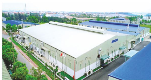
Dự án Nhà máy Doosan Hải Dương
