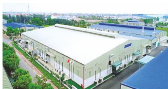
Dự án Nhà máy Doosan Hải Dương
