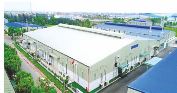
Dự án Nhà máy Doosan Hải Dương
