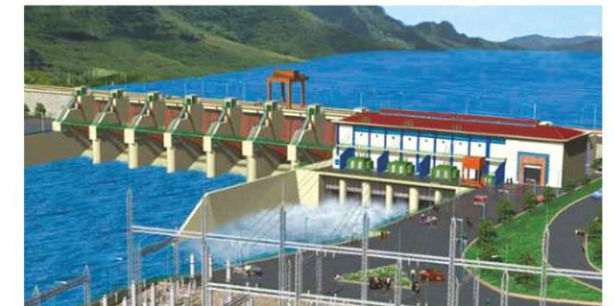
Dự án Nhà máy thủy điện Bảo Nhai - Lào Cai
